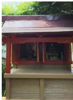
改修された御堂です
